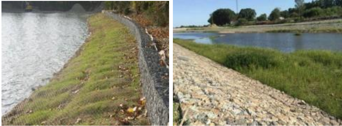
图 8.1-3 格宾网（生态格网）护面效果图
