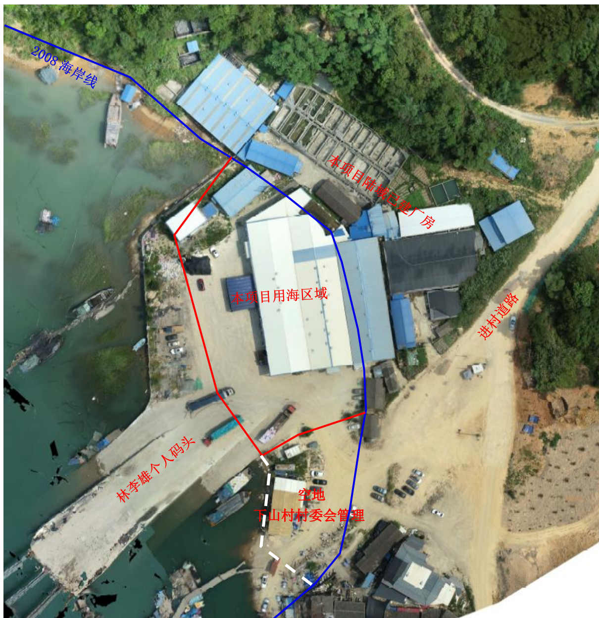
图 3.1-2 霞浦县海淼水产有限公司物资仓储项目航拍图
